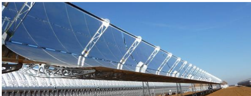
Figura 2.2. Colector solar de canal parabólico, (Energía Solar térmica de alta temperatura, 2016).
