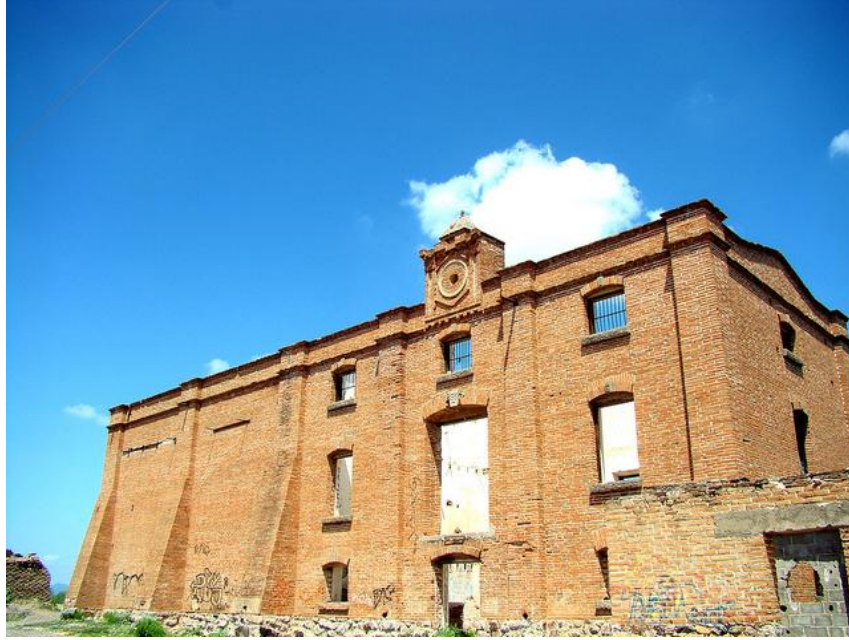
Molino de "Codórachi", (1915), Villa Pesqueira Contrafuertes, arcos de doble dovela de cerramientos en ventanas, remates en pretilos (Foto L.A.U.V.)
