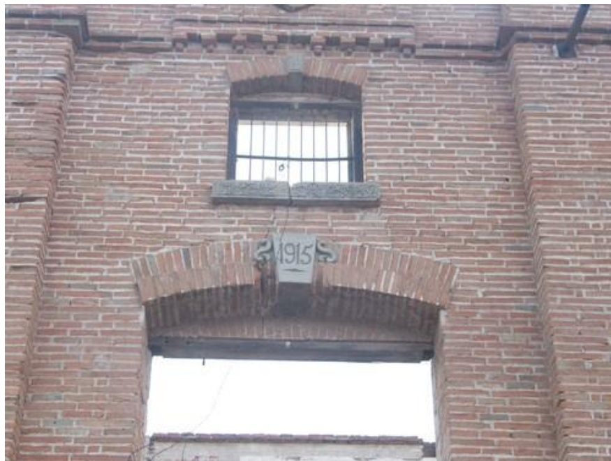
Molino de "Codórachi", (1915), Villa Pesqueira Contrafuertes, arcos de doble dovela de cerramientos en ventanas, remates en pretilos (Foto L.A.U.V.)
