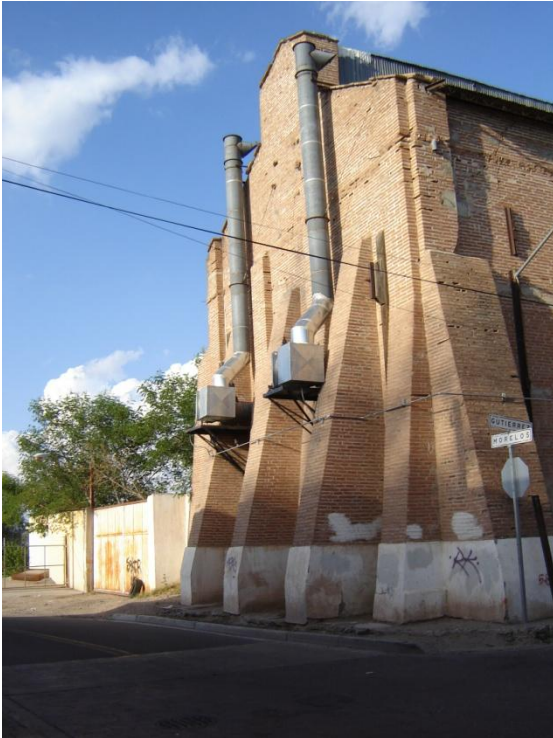
Molino Moderno (1918), en Villa de Seris, Hermosillo Contrafuertes de ladrillo (Foto L.A.U.V.)
