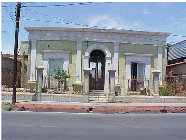
Vivienda en Hermosillo, Son . Foto L.A.U.V.
