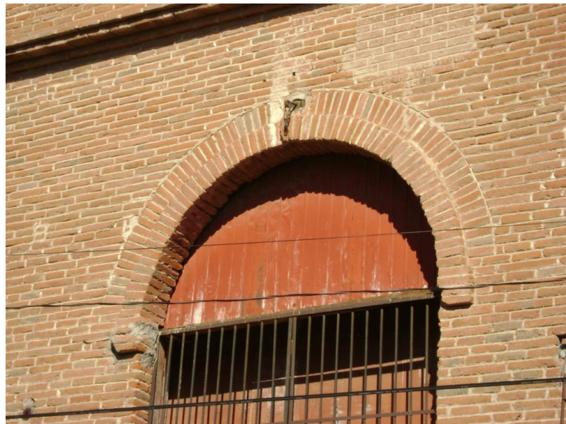
Molino Moderno (1918) en Villa de Seris, Hermosillo Arco de medio punto, dos hiladas a tizón. (Foto L.A.U.V.).
