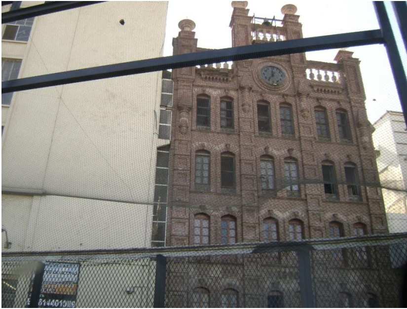
Molino "La Fama" (1900), Hermosillo. Arcos en ventanas, almohadones de ladrillo, Reloj fabricado en 1892, por la compañía E.Howard & Co. De Bostón, Massachusetts en Estados Unidos. (Foto tomada de Foto galería del Imparcial).
