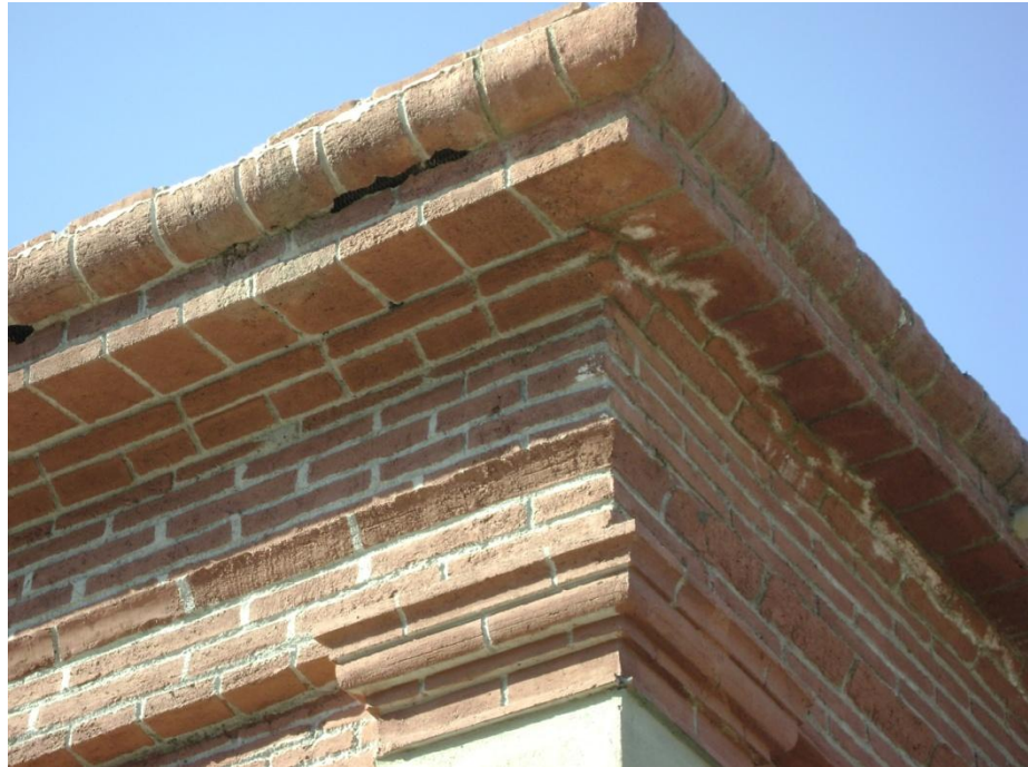
Casa en Villa de Seris, Hermosillo Capitel de columna y cornisa de remate en pretil. (Foto L.A.U.V.)
