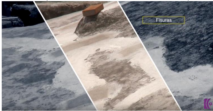
Figura 85. Resanado del agrietamiento en el extradós de la bóveda (Monzalvo, 2019).
