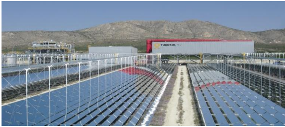
Fig. 1.8 Sistemas de concentración solar tipo Fresnel.
