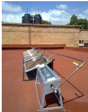
Figura 3 7 Azotea del CHICAp vista general de los concentradores, tuberías y tanque de alimentación y tanque de recepción.
