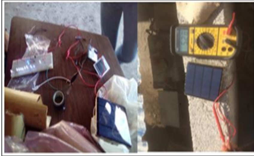
Figura 3.16. Pruebas de carga y descarga de la fuente de almacenamiento y prueba al panel solar.
