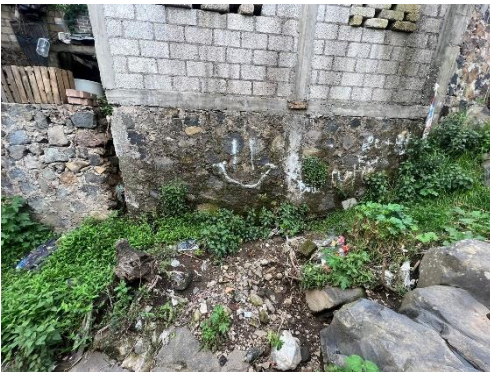
Imagen 8 –cimentación de vivienda en la barranca Cuatizec.
