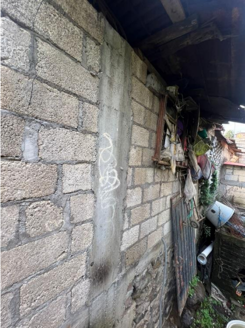
Imagen 12 – Muros de la vivienda en la barranca Cuatizec.
