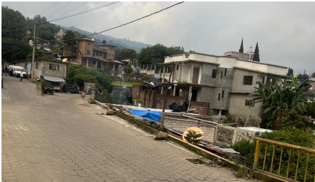
Imagen 5 – Calle Inés Chaves de acceso a vivienda en la barranca Cuatizec.
