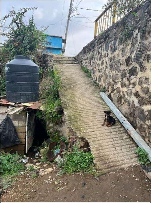
Imagen 7 – Acceso principal a vivienda en la barranca Cuatizec.
