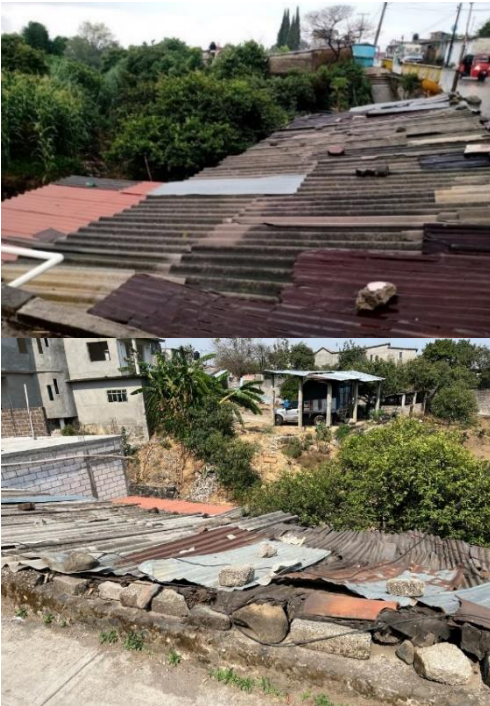
Imagen 13 – Muros de la vivienda en la barranca Cuatizec.
