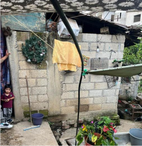
Imagen 10 – Columnas de vivienda en la barranca Cuatizec.
