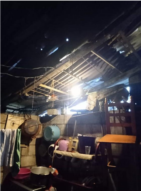
Imagen 11 – Vigas de la vivienda en la barranca Cuatizec.
