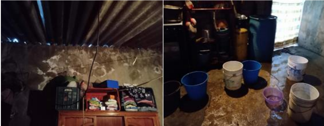
Imagen 28 – Problemas en las viviendas de la barranca Cuatizec, en el municipio de Tlalnepantla Morelos.
