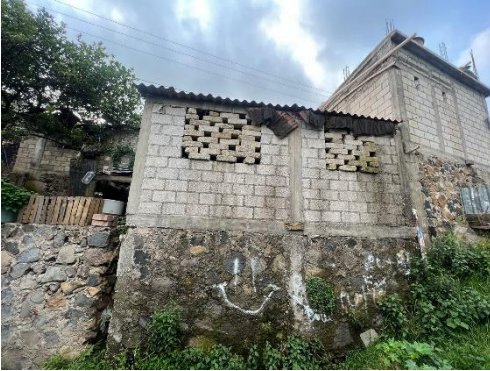
Imagen 14 – Ventanas de la vivienda en la barranca Cuatizec.
