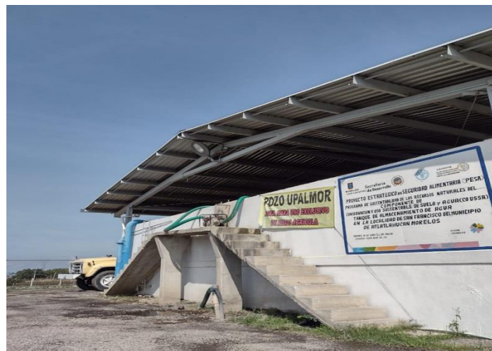
Foto 3. Pozo de agua de la plaza Mor-Mex
