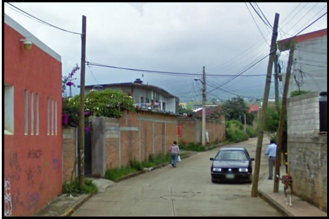
Imagen 20 Invasión de Banquetas con Postes para infraestructura. Fuente: Propia.
