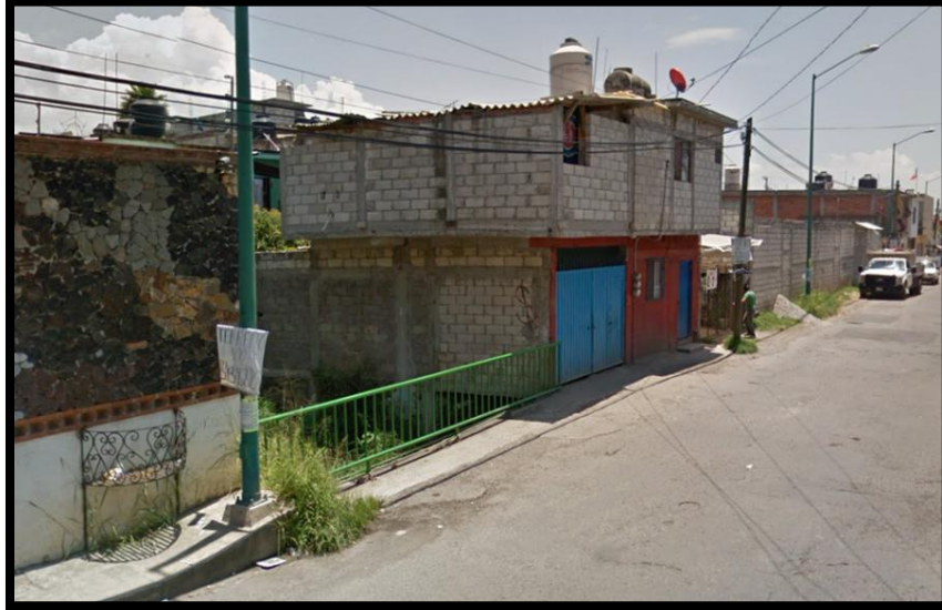
Imagen 8 Puesto de Barranca Seca en Avenida Lomas de Cortes. Fuente: Propia.
