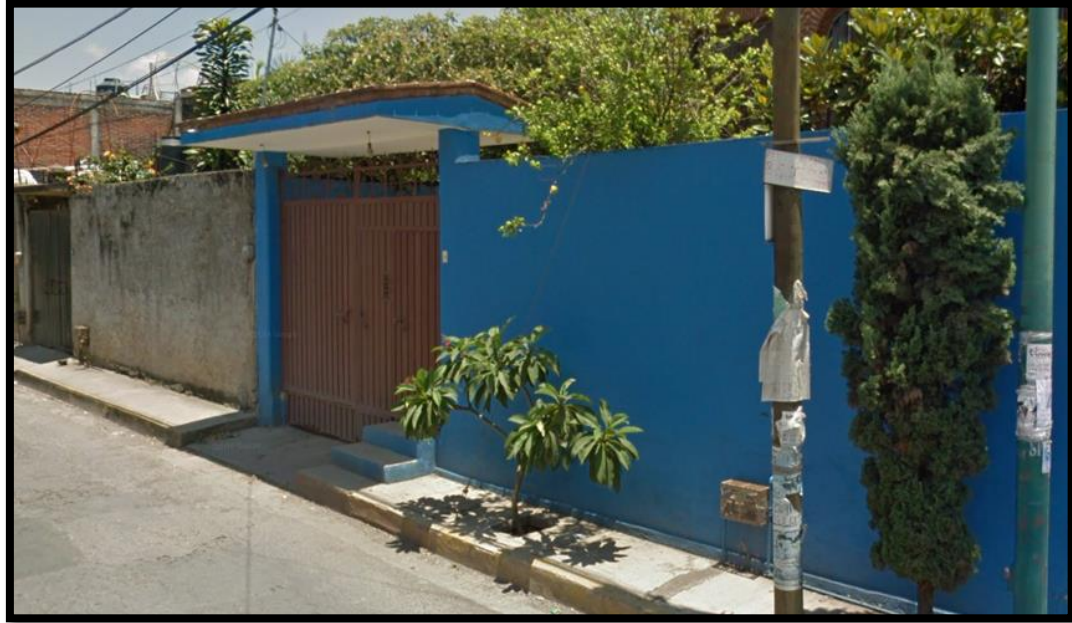
Imagen 16 Obstrucción de Banquetas por accesos domiciliarios (escaleras). Fuente: Propia.
