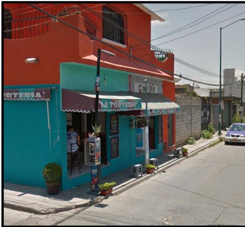
Imagen 17 Obstrucción de Banquetas por casetas telefónicas. Fuente: Propia.
