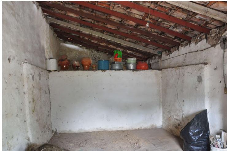
Interior de la vivienda separando los cuartos por un muro que no llega hasta el techo. Actualmente se usa como bodega.
