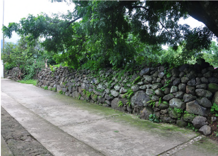
Tecorral del predio hacia la calle.
