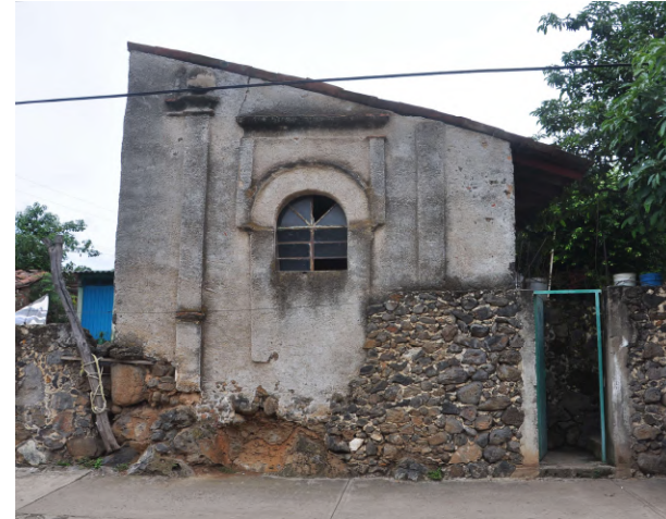
Fachada de la vivienda tradicional de San Andrés de la Cal con aplanado de cal. Fotografía: S.M.R.
