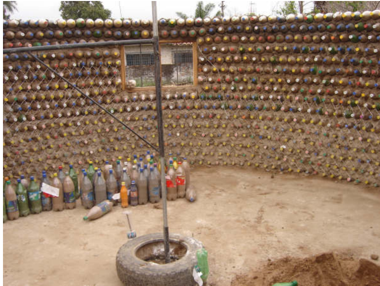
Construcción con botellas de Pet rellenas con tierra y colocadas una sobre otra sobre una mezcla de tierra y cemento, posteriormente se amarran las tapas haciendo una malla y se aplanan con tierra.
