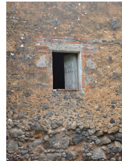
Detalle de las ventanas, la vista es remetida por dentro, lo cual permite una abertura para ver desde adentro y no desde afuera.
