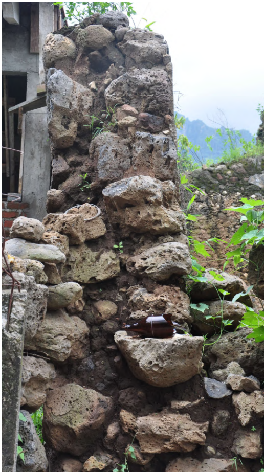
Detalle de la estructura y elaboración de los muros: piedra, tierra y cal.
