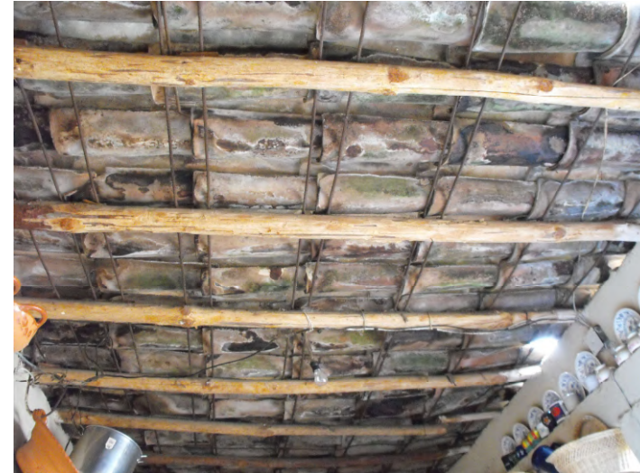
Detalle de las tejas, sostenidas por morillos
