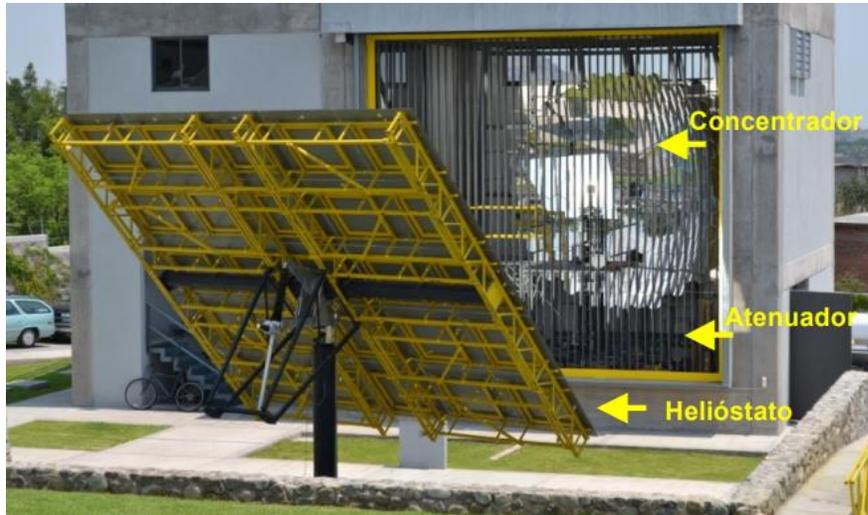
Figura 1.4: Horno Solar de Alto Flujo Radiactivo, en el IER-UNAM, Temixco Morelos. Tomada de Licurgo-Pedraza (2012).
