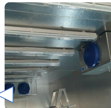
Fijación de luminarias
