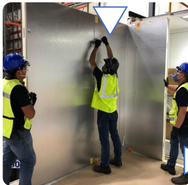
Armado de muros
