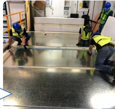
Colocación de piso
