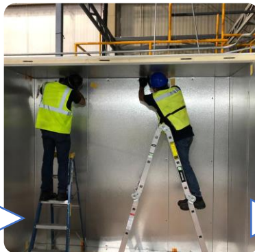
Colocación de techo
