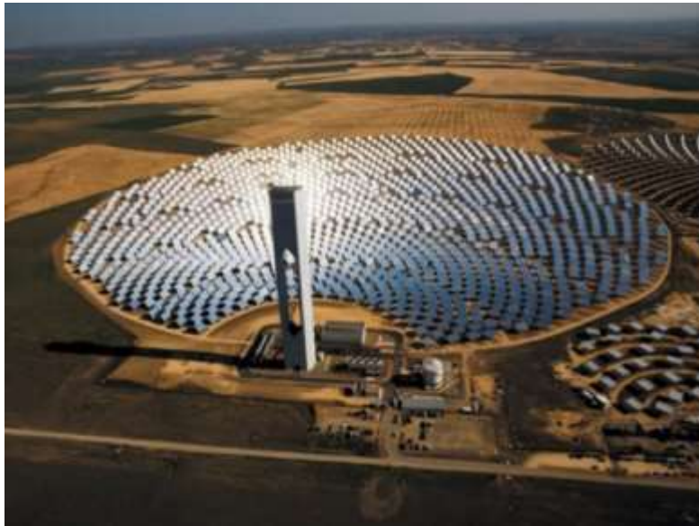
Figura 2.7 Torre de energía solar PS-10 de 10 MW en Sevilla, España. ( Md Tasbirul, et al.,2018 )
