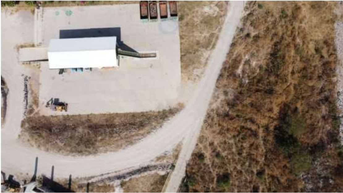
Figura 16. Parte de la esquina nororiente del predio, donde se puede ver las instalaciones abandonadas de la planta de valorización de residuos del gobierno del estado de Morelos..
