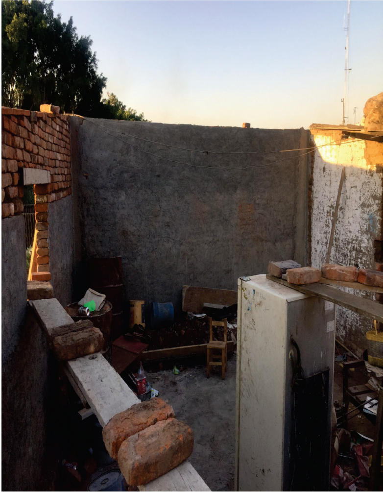
FIGURA 23. INTERIOR DE VIVIENDA CONSTRUIDA CON LADRILLOS REUTILIZADOS
