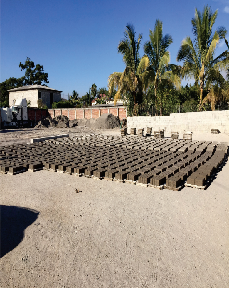
FIGURA 10. SECADO DE LOS BLOQUES DE CONCRETO
