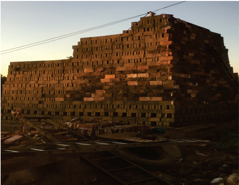
FIGURA 15. HORNO DE LADRILLO
