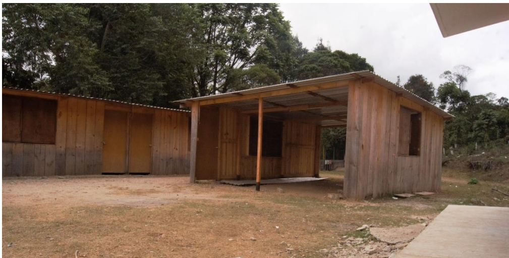
Imagen 6 Instalaciones del Colegio de Bachilleres de la localidad de Laguna del Cofre (Fuente propia)
