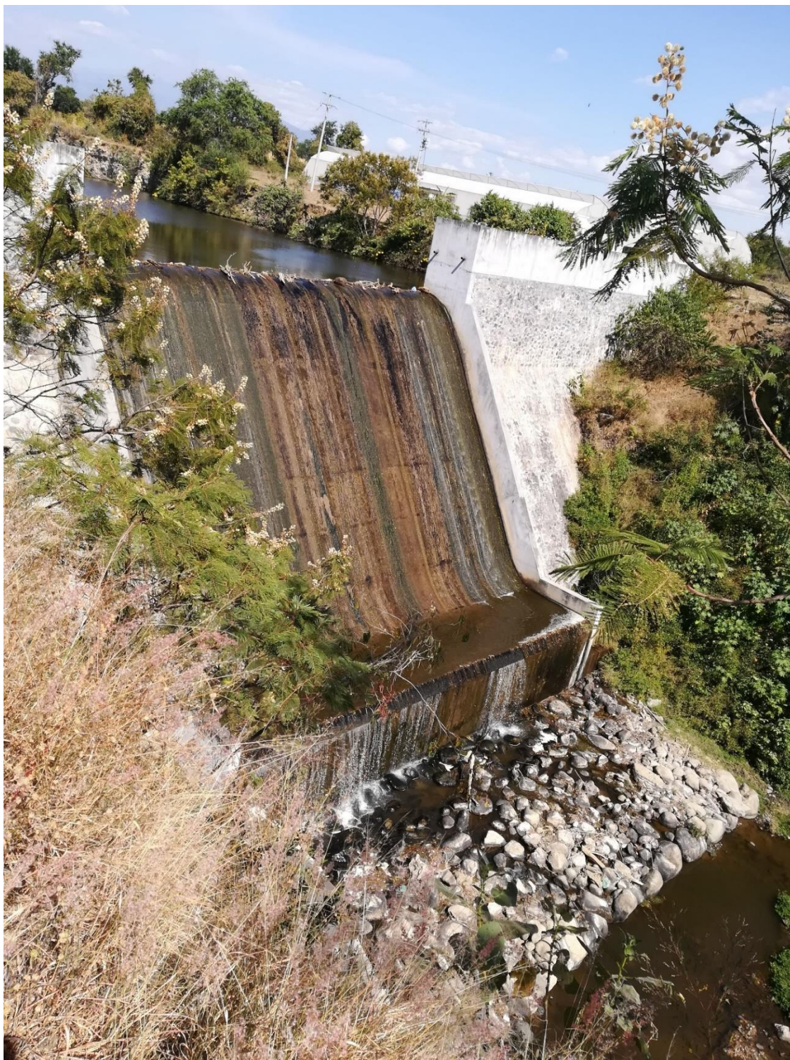
Foto 11. Presa Amilcingo. Huazulco, Morelos. 19 de noviembre de 2017. Foto de ENG.
