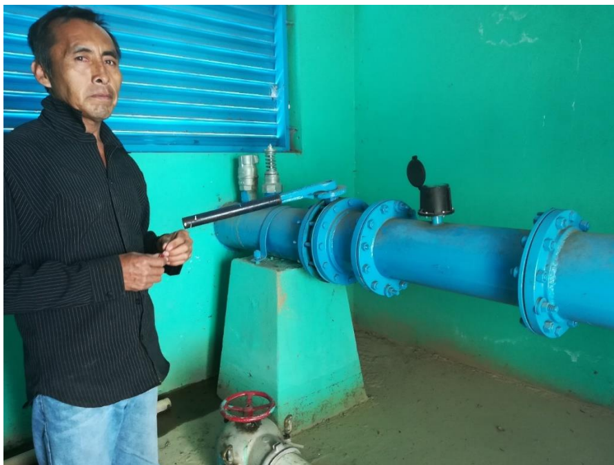
Foto 9. Válvulas principales en presa Socavones y representante del riego Huazulco. Zacualpan de Amilpas, Morelos. 19 de noviembre de 2017. Foto de ENG.
