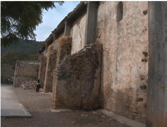
Figura 5.8. Muestra representativa de los daños ocasionados en la estructura del templo de Santa María de la Asunción, en la comunidad de Tlamacazapa, foto autora.
