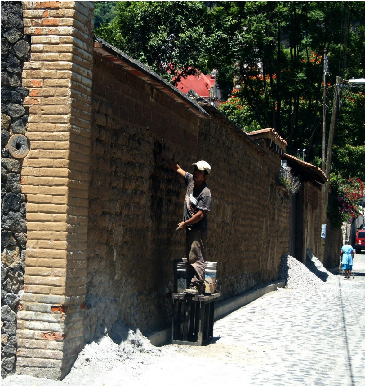
Imagen que muestra el uso del adobe de las viviendas en el pueblo de Malinalco, así como el uso de tabique en remates de elementos constructivos (Cuevas, Fotografía, 2019)
