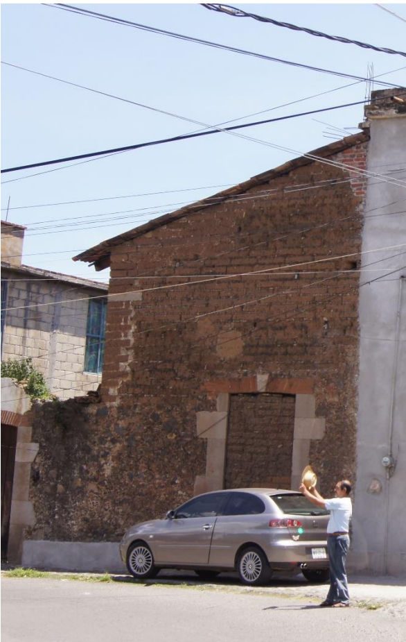
Imagen que muestra el uso del petatillo en una cubierta de vivienda vernácula en el pueblo de Malinalco (Cuevas, Fotografía, 2019)
