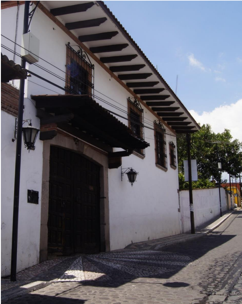
Imagen que muestra el sistema constructivo de vigerías en las viviendas en el pueblo de Malinalco (Cuevas, Fotografía, 2019)
