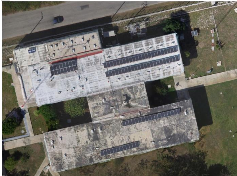
Figura 95 – Imagen original de edificio a evaluar
