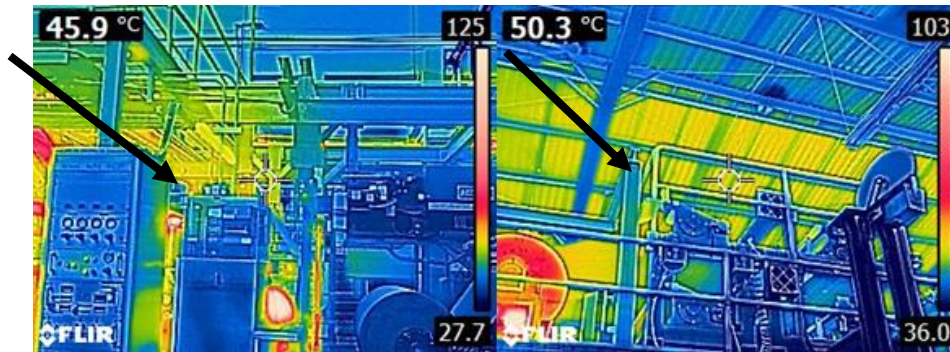
Figura 2.7. Fotografía termográfica de la zona de doble engomador.
