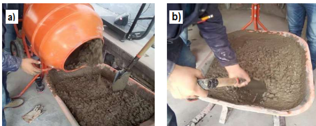
Figura 3.11. a) Colocación del concreto a la carretilla, b) Remezclado del concreto fresco para pruebas físicas.
