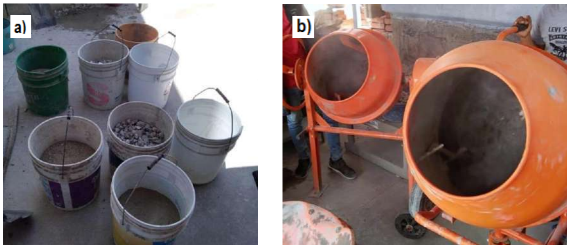
Figura 3.10. a) Peso de los materiales colocados en recipiente b) Vaciado del material a la revolvedora.
