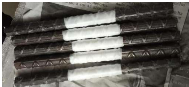
Figura 3.17. Limpieza de varillas y preparación con cinta de teflón.
