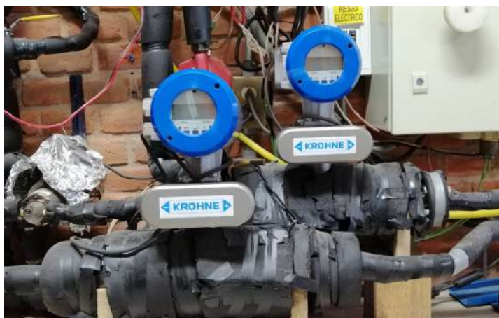
Figura 3.11: Caudalímetro másico Coriolis
