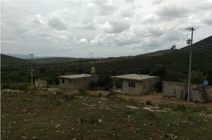
Figura 4 Casa de David (10) y Soledad (11). Casa en construcción de Martín (14) y Renata (15)
