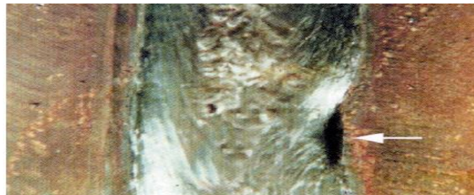
Figura 2-16 Falta de fusión entre el metal de soldadura y el metal base.
