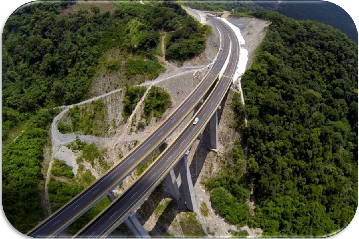
Imagen 6. Autopista México – Tuxpan (IMCYC 2012)
