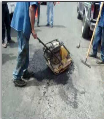
Imagen 8. Bacheo con concreto y llantas usadas.
