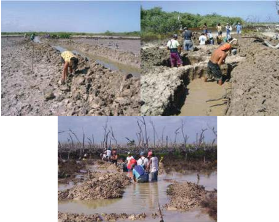
Figura 4 Apertura del canal principal de la zona de rehabilitación
