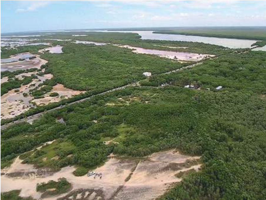
Imagen 1 Carretera para ingresar al pueblo de Celestún, Yucatán
