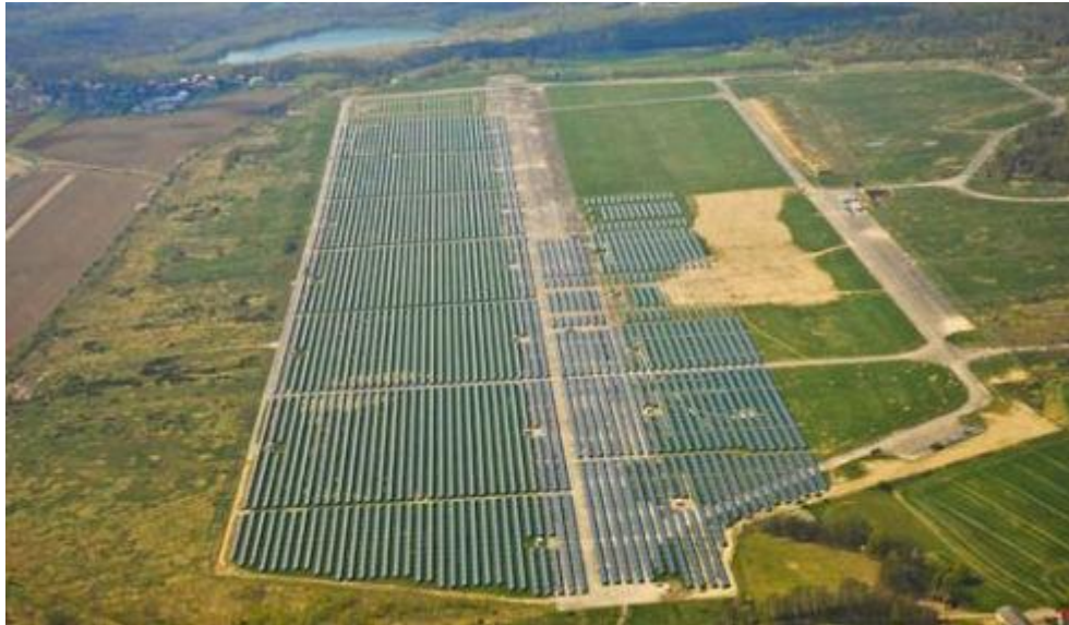
Figura. 6.4 Planta Solar de 40 MW Waldpolenz Alemania
