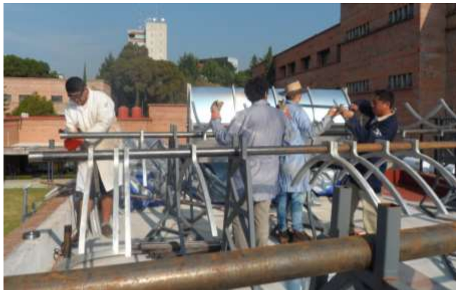
Figura 3.11 Ensamble de los perfiles parabólicos.
