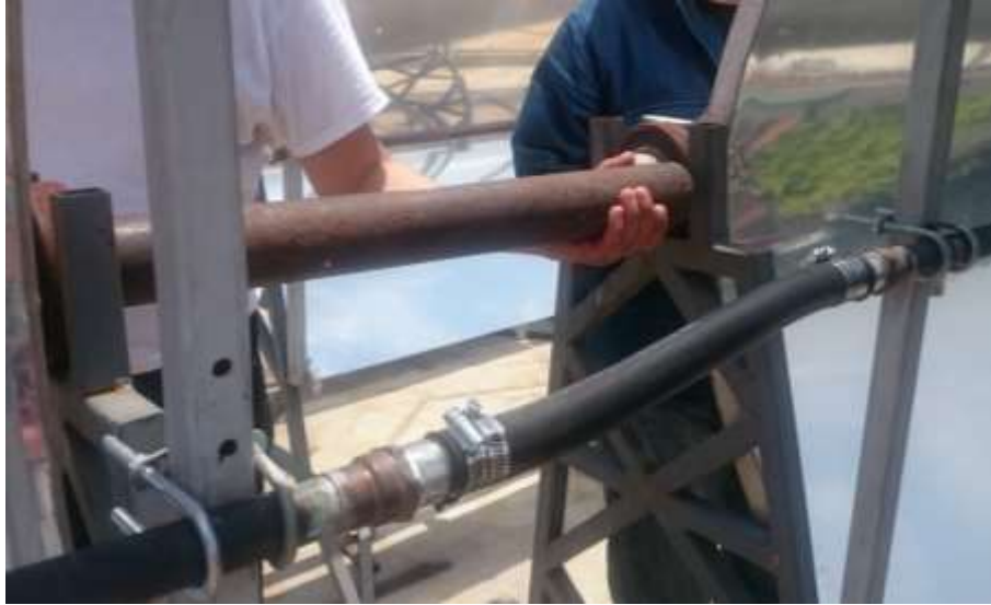
Figura 3.24 Instalación del tubo que conecta dos dispositivos.
