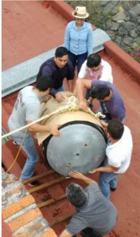
Figura 3.18 Colocación termotanques 3.
