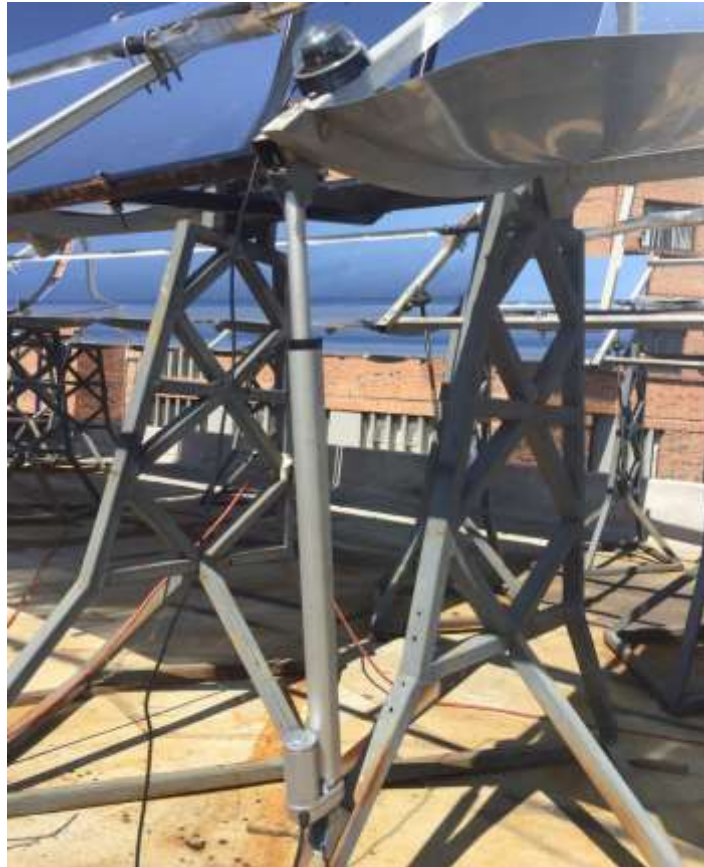
Figura 3.26 Instalación de sistema de seguimiento mecánico.
