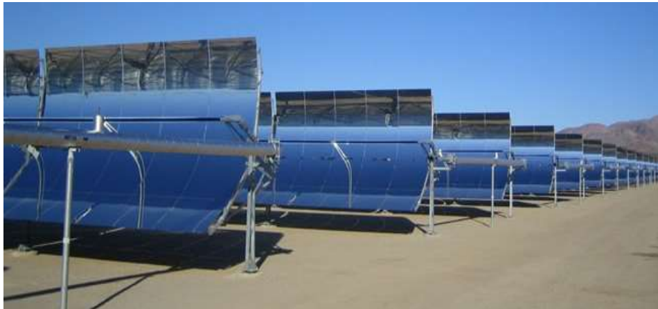
Figura 2.3. Colectores cilindro-parabólicos.
