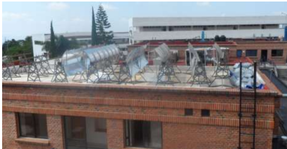
Figura 3.15 Construcción de los concentradores parabólicos.
