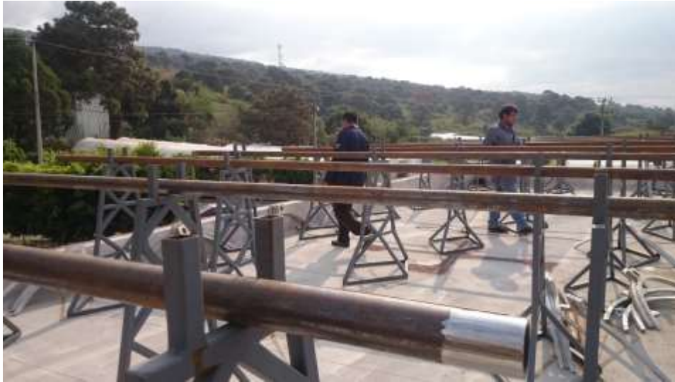
Figura 3.10 Ensamble de tubos estructurales.
