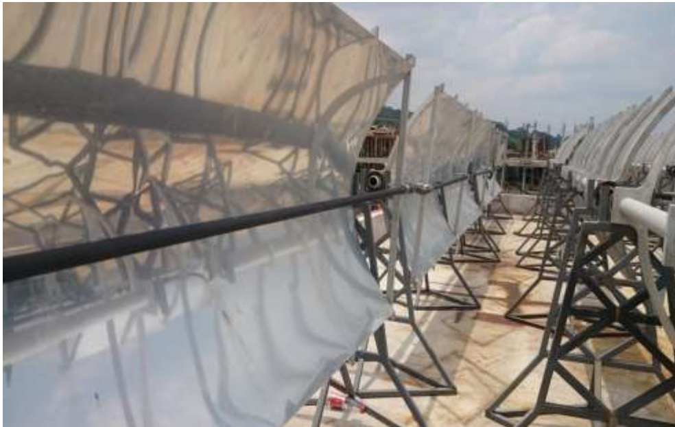
Figura 3.22 Instalación del sistema hidráulico de los concentradores.
