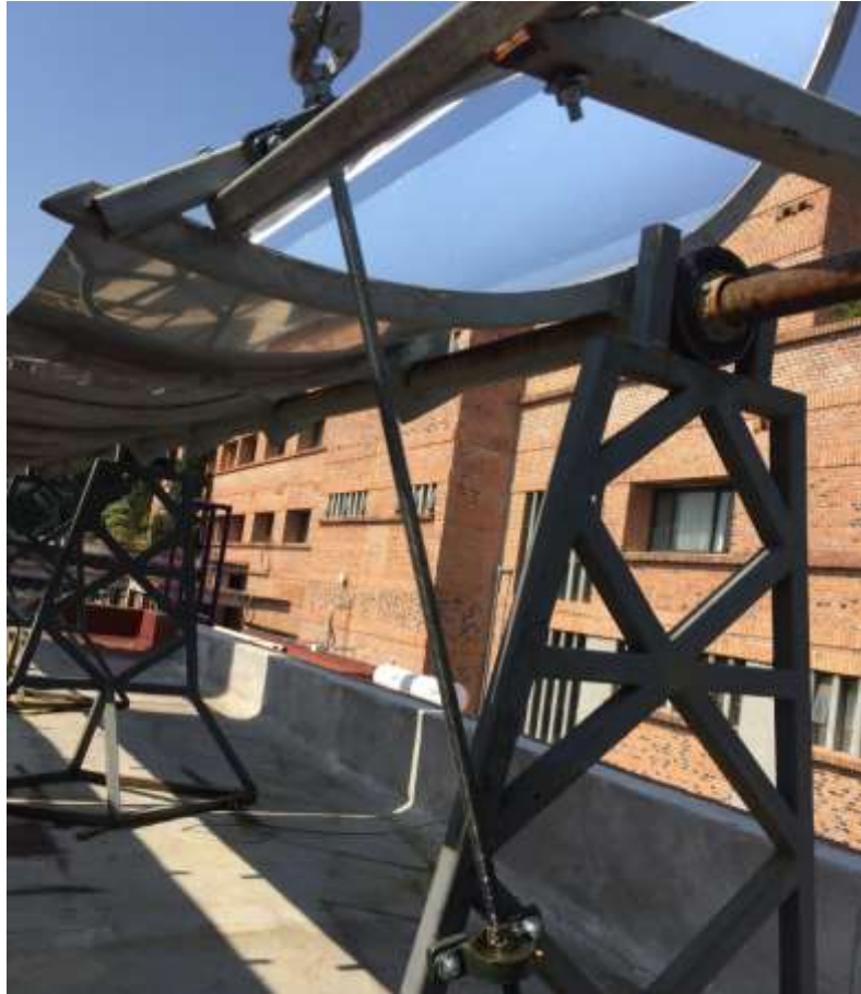
Figura 3.27 Instalación de sistema de seguimiento manual.
