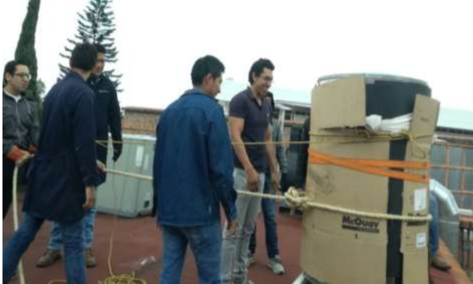
Figura 3.16 Colocación de los termotanques.
