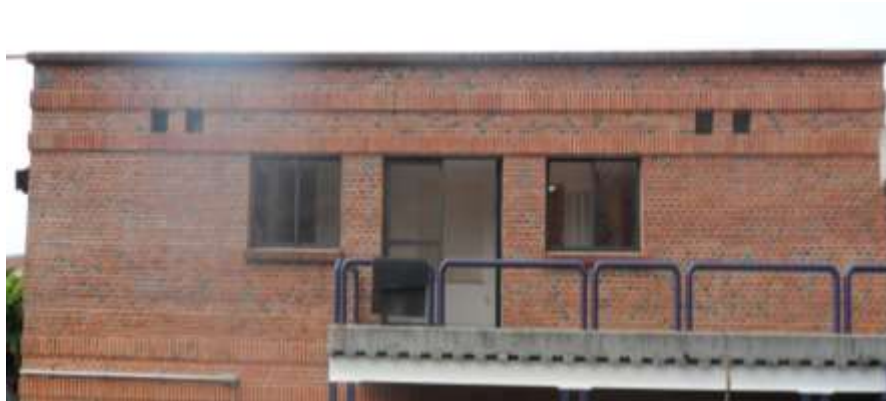
Figura 3.1 Vista frontal del edificio “cubículos 2”, [Galindo-Luna 2015].
