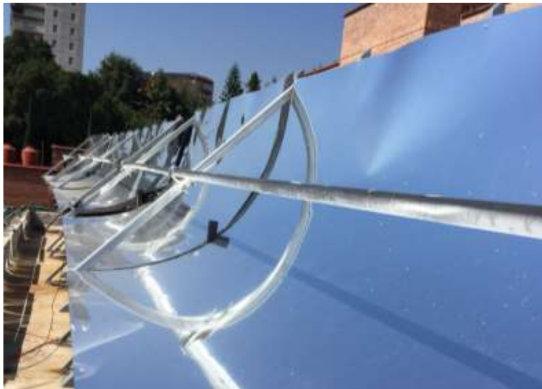
Figura 3.28 Pruebas del sistema de seguimiento solar.
