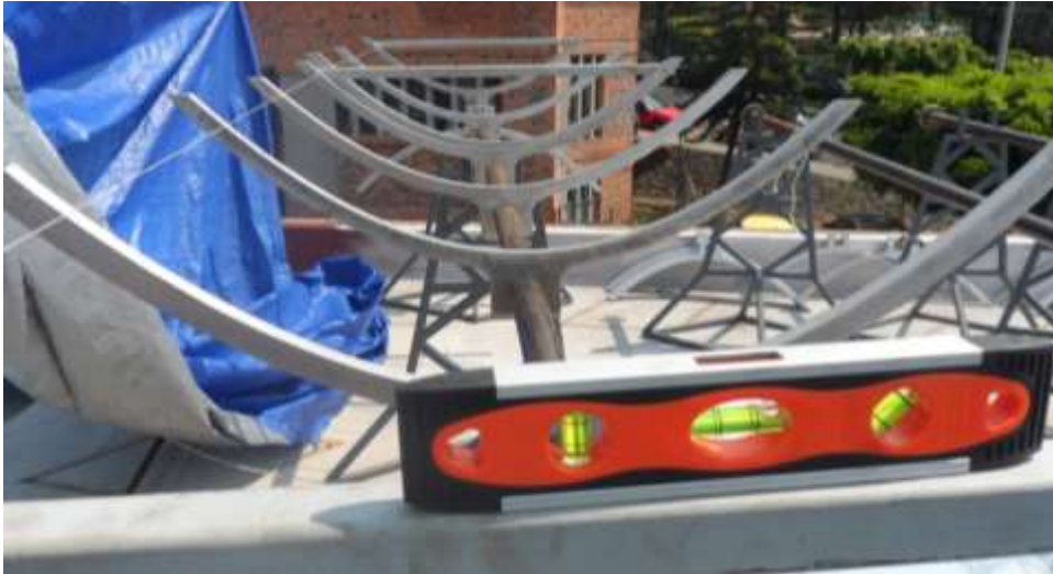
Figura 3.12 Alineamiento de perfiles parabólicos.
