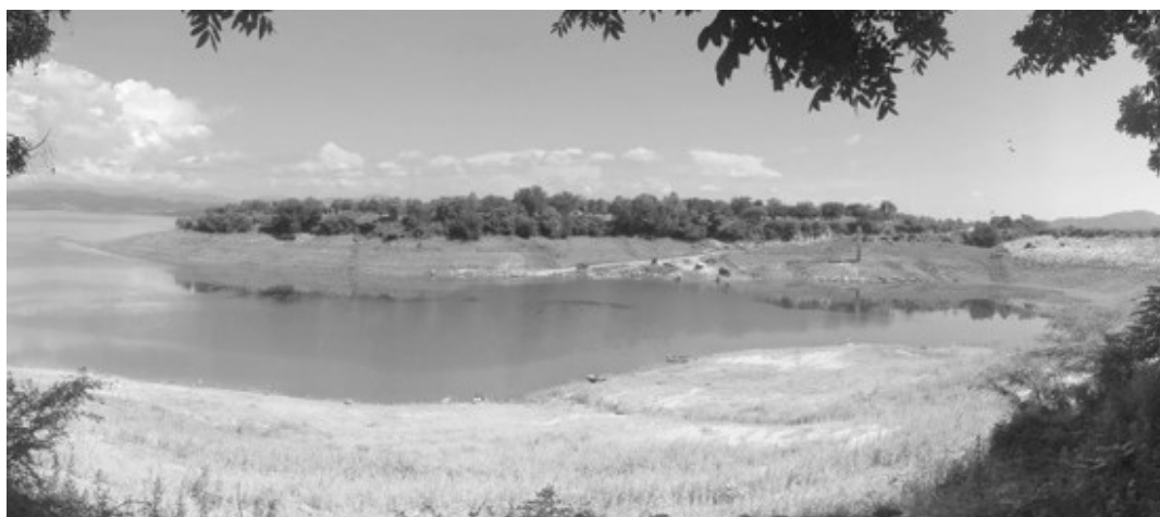
Fotografía 29. Panorámica de la presa Sanalona desde El Templete, Sanalona, Culiacán.
