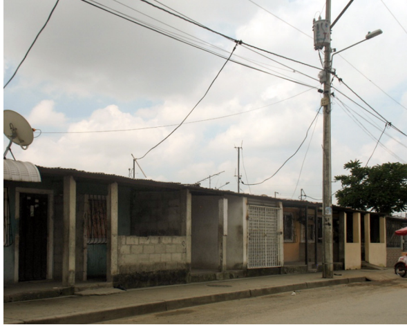
Existen pocos cambios realizados en fachada que indiquen generación de pertenencia de los moradores hacia sus viviendas.
