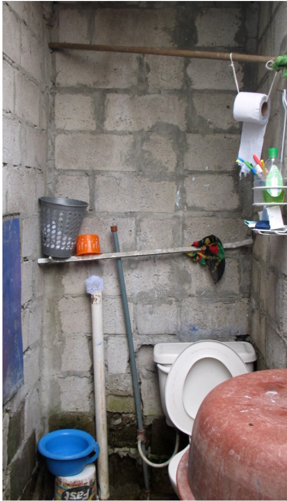
En varios casos el patio posterior ha sido destinado a baño para así agrandar la zona social.
