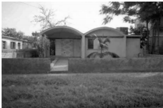
Imagen 13. Primera vivienda construida con bloques machihembrados de suelo cemento. Ciudad de Matanzas. 1992 Fuente: (González, 2009)
