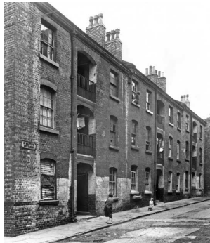
Imagen 6. St Martin's Cottage, 1954 Fuente: https://bit.ly/2l14uHq
