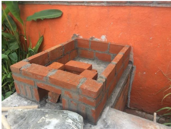
Figura 3.3 Construcción de la cámara de combustión
