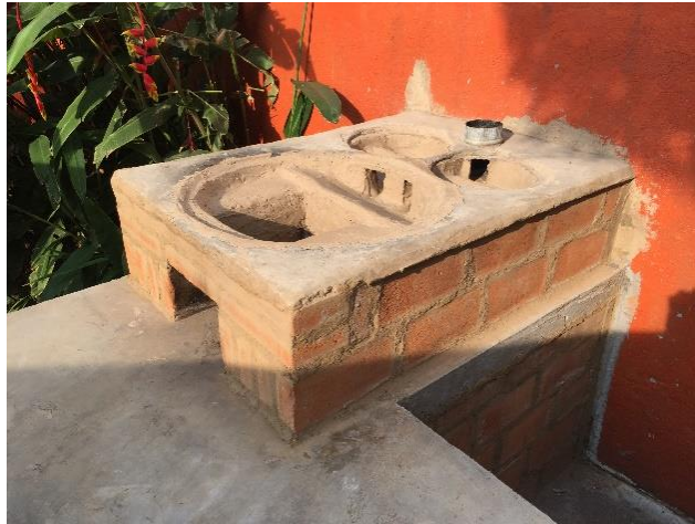
Figura 3.7 Colocación del barro refractario
