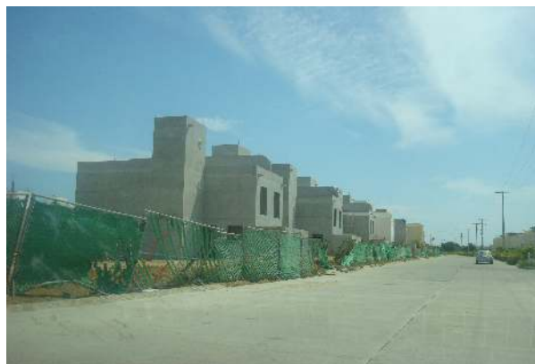
Foto 3.38 Vista de construcción de nuevas viviendas que formaran parte del mismo fraccionamiento.
