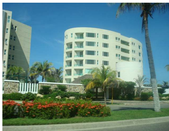
Foto 4.2 Departamentos en el espacio turístico de Acapulco Diamante, sobre el Boulevard a Barra Vieja, que tienen vista hacia la playa.
