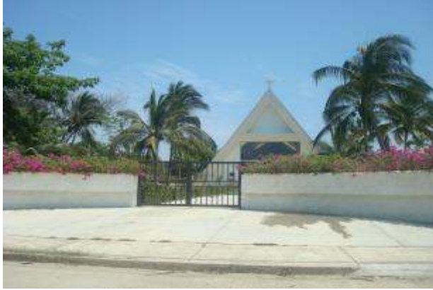
Foto 3.13 Vista del acceso principal de la Iglesia la cual está en buen estado físico.
