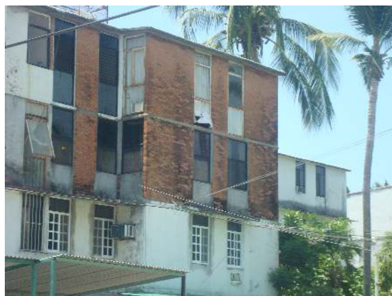
Foto 4.6 Vista de edificios en la Unidad Habitacional Guerrero 200.
