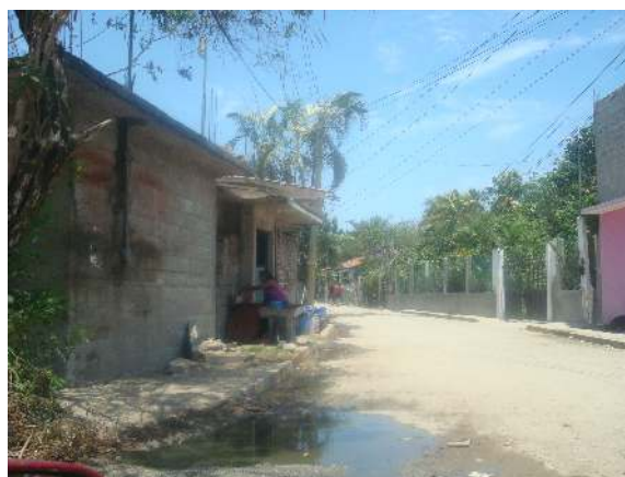
Foto 4.8 Vista de la colonia La Zanja, donde se aprecia el estado físico de algunas edificaciones.
