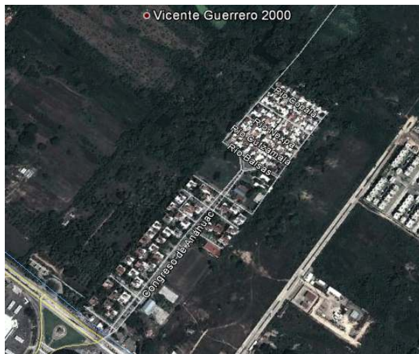
Imagen 3.4 Vista aérea de la Unidad Habitacional Vicente Guerrero 200. Fuente: Google earth, 2017.
