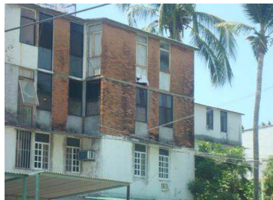
Foto 3.22 Esta imagen muestra el deterioro físico de los edificios
