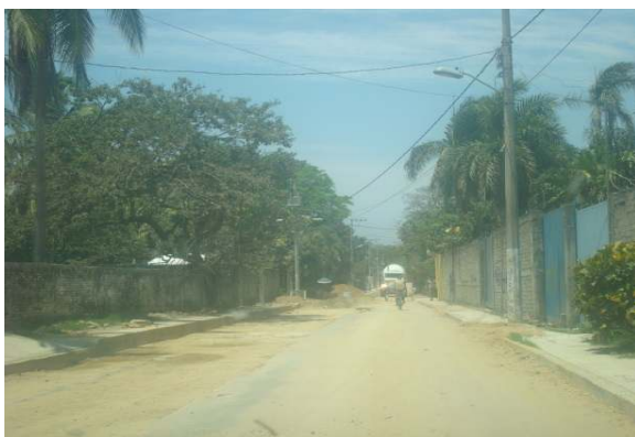
Foto 3.1 Vista de la vialidad principal de la colonia La Zanja en proceso de pavimentación.
