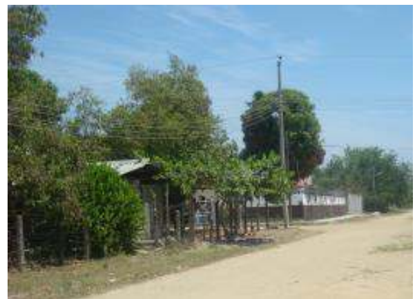
Foto 3.16 Aspecto físico vivienda precaria.
