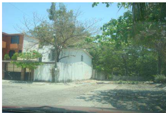
Foto 3.24 Vivienda unifamiliar y vialidad cerrada en deterioro.
