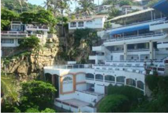
Foto 2.1 Hotel "La Quebrada" en la zona tradicional de Acapulco. Fuente: propia, 2014.
