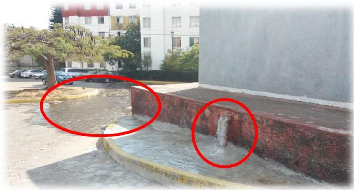
Figura 21. Desperdicio de agua por descuido del sistema de bombeo de agua del CAV. Fuente: Arce, 2019
