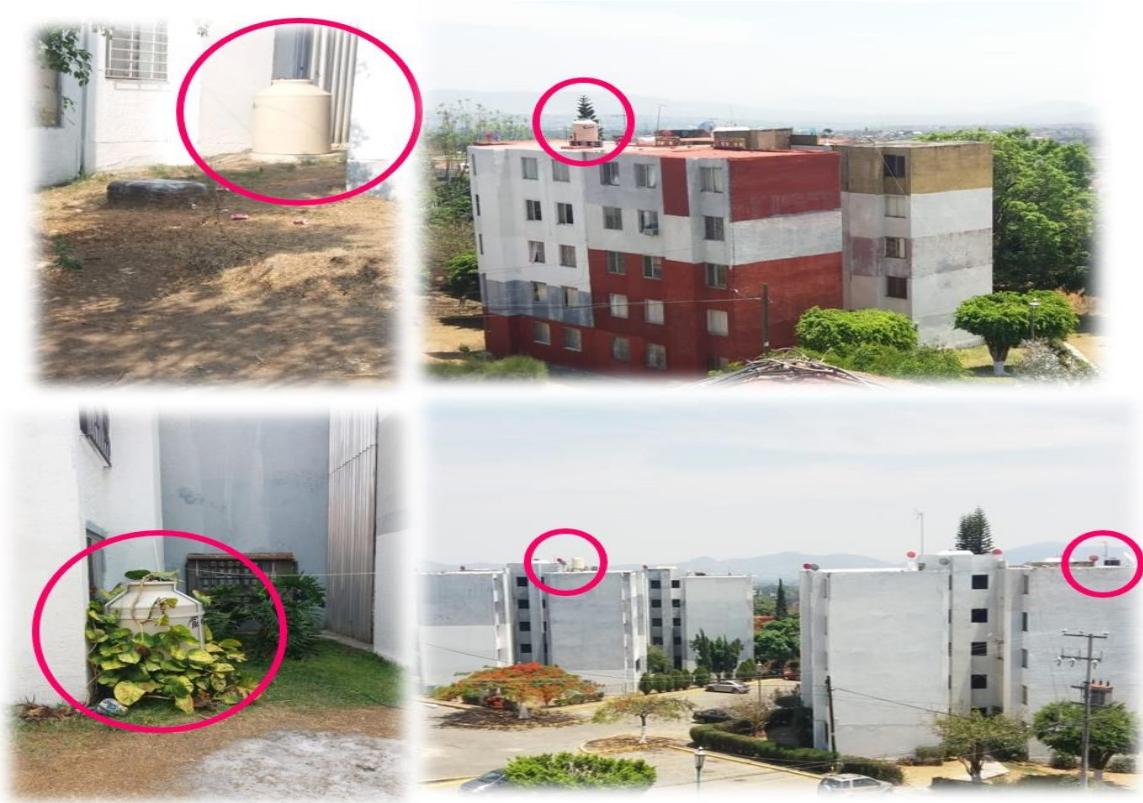
Figura 19. Tinacos instalados en azoteas y áreas de jardín del CAV. Fuente: Arce, 2019.
