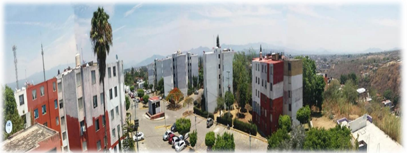
Figura 24. Fachada de edificios del CAV. Fuente: Villamil y Arce, 2019.
