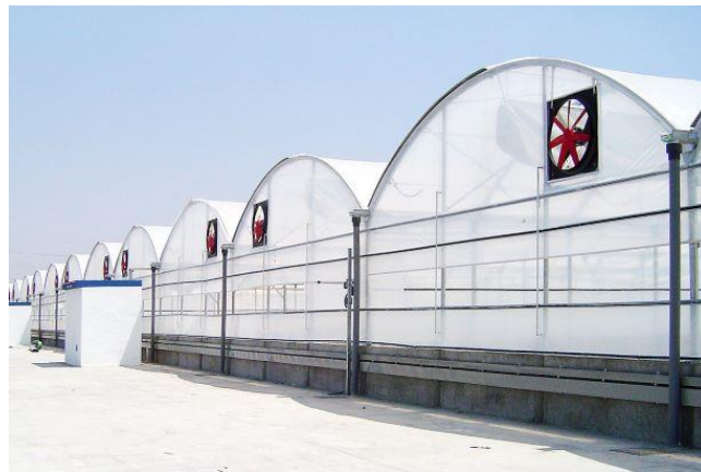
Figura 1.2 Invernadero multicapilla con sistema de ventilación
