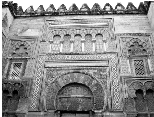
Figura 9. Exterior de la Mezquita Aljama de Córdoba. Arquitectura cordobesa.
