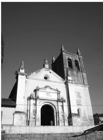
Figura 66. Torre-fachada en iglesia de Copainalá. Fotografía: Esquinca Cruz, 2013
