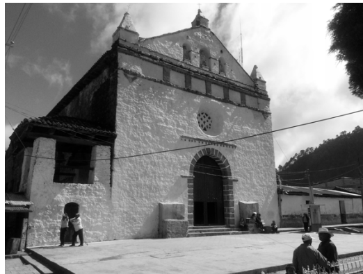
Figura 50. Fachada principal con óculo, iglesia de Tapalapa. Fotografía: Figueroa Esquinca, 2013
