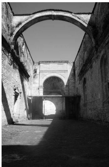
Figura 63. Cubierta interior en Tecpatán, inexistente. Fotografía: Figueroa Esquinca, 2013
