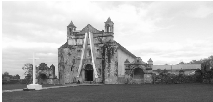
Figura 55. Contrafuertes esviajados en fachada, templo de Tumbalá. Fotografía: Figueroa Gallegos, 2013
