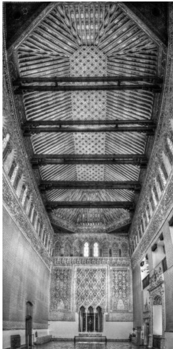
Figura 15. Techumbre de la Sinagoga del Tránsito, Toledo, España.
