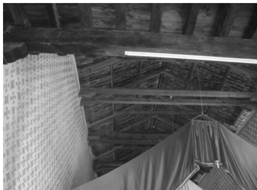
Figura 59. Cubierta interior en Sitalá. Armadura par y nudillo. Fotografía: Figueroa Esquinca, 2013
