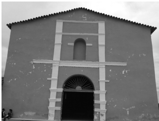
Figura 51. Fachada principal con acceso y hornacina, iglesia de Suchiapa. Fotografía: Figueroa Esquinca, 2013
