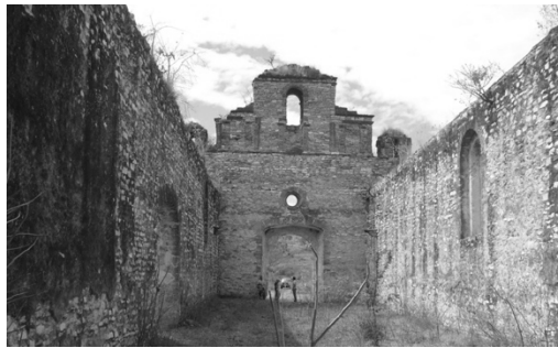
Figura 58. Cubierta interior en Coneta, inexistente. Fotografía: Figueroa Gallegos, 2013
