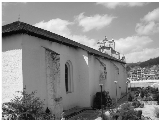
Figura 53. Contrafuertes rectangulares en exterior, templo de San Juan Chamula. Fotografía: Figueroa Esquinca, 2013
