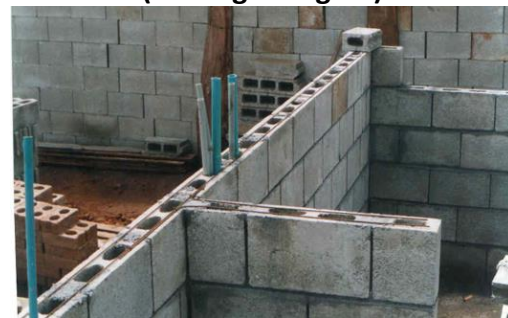
(Muros con refuerzo interior)
