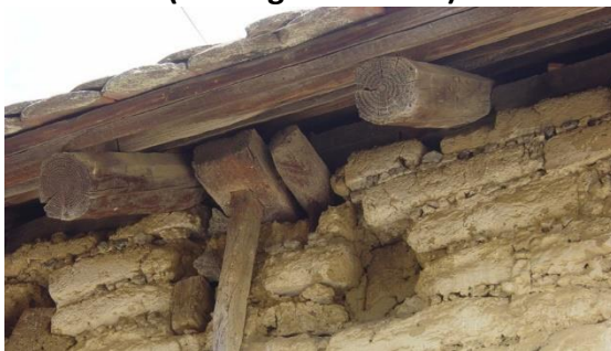
(Muros sin refuerzo interior)
