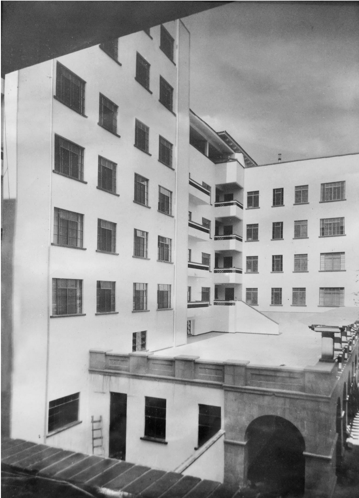
Imagen 27 Padilla, Ulises 2017 Vista de terraza existente cuando era hotel. Recuperado de cuadro del Hotel casa latinoamericana, proporcionado por José Antonio Gumler
