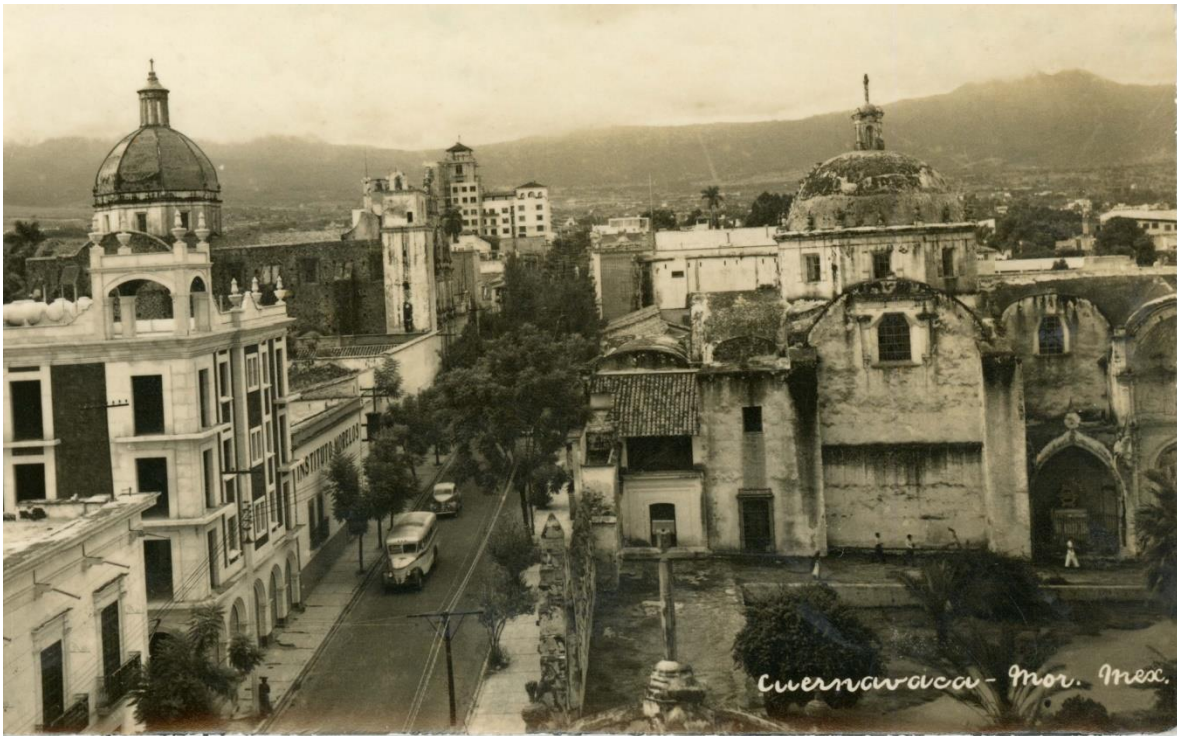
Imagen 34 Vista desde la catedral de Cuernavaca, apreciando el edificio de la casa latinoamericana. Proporcionada por el Arq. Alfonso Toussaint
