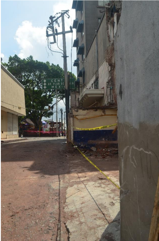
Imagen 80 Padilla, Ulises 2017. Vista calle Santos degollado
